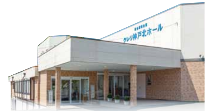
クレリ神戸北ホール外観
